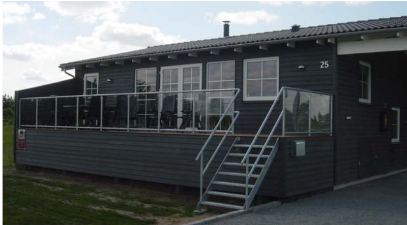
Terrasse som er hævet over terræn. Galvaniseret gelænder med glasplader, så søudsigten kan nydes fra alle positioner.
